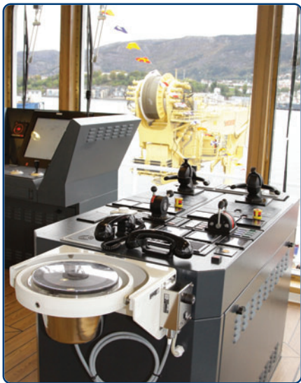
„Zapasowa sterówka” z systemem DP - oddzielne pomieszczenie przy gł. sterowni.
