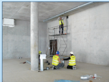
Na placu budowy pracują już pierwsi robotnicy.
