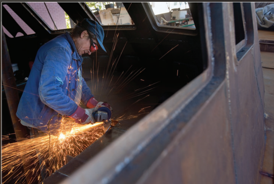
Sławomir Michalski przychodzi na budowę codziennie.
