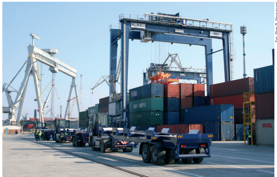
Nowoczesne suwnice bramowe na placu składowym Gdynia Container Terminal. Po lewej, w tle, widoczna suwnica w Stoczni Gdynia S.A.
