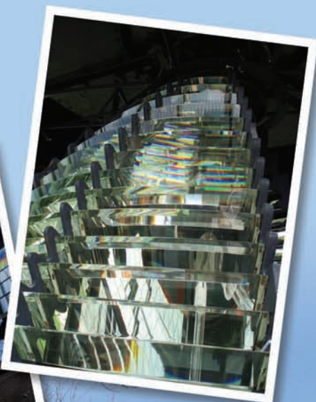
Soczewka Fresnela – w systemie świetlnym latarni do roku 1927 r.
