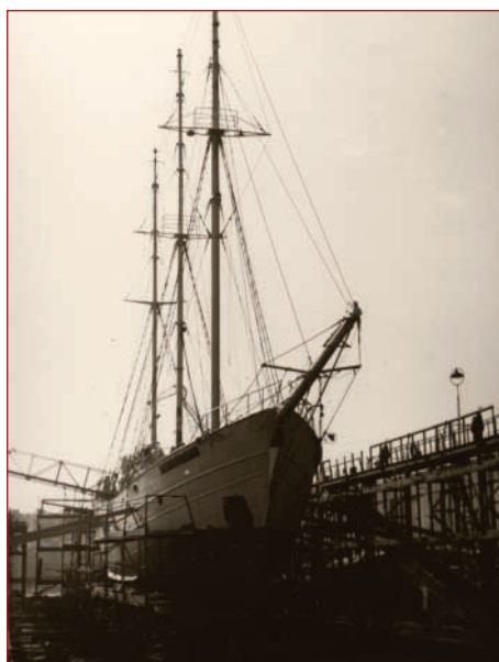
Zawisza podczas remontu w Stocznii Komuny Paryskiej.
