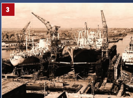
3 Lata 50 i 60 ub. wieku. W stoczni remontowano głównie statki z tzw. bloku wschodniego. Jeszcze w 1990 roku kierunki sprzedaży były następujące: 58% - ZSRR, 34% Polska i 8% - Europa Zachodnia. Dopiero w 2001 te proporcje się odwróciły: 86% - rynki zachodnie, 10% - Polska i 4% - kraje byłego ZSRR. Dzięki wprowadzaniu w stoczni od roku 1989 nowoczesnego marketingu, w ciągu 10 lat Remontowa dokonała całkowitej reorientacji rynkowej.
