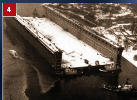
4 W latach 70. ub. wieku stocznia, obok wykonywania remontów, produkowała także doki. W roku 1975 zbudowała dok o nośności 55 tys. ton dla szwedzkiej stoczni w Goeteborgu, największy wówczas dok pływający, który powstał w Europie. Operację wykonano nowatorską metodą spawania bloków pod wodą w specjalnym tunelu.
