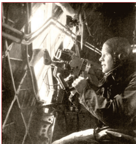
Stanowisko strzelca bocznego w Wellingtonie.
