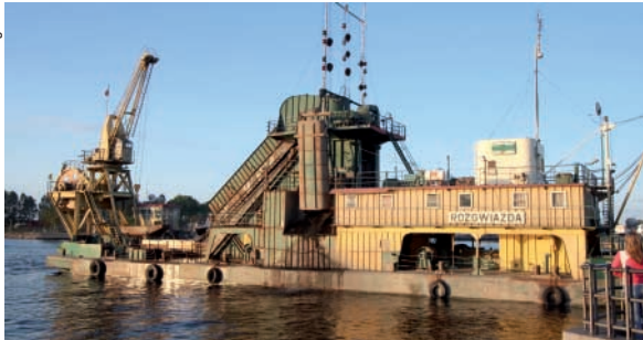
Pogłębiarka Rozgwiazda przejęta przez PRCiP z Gdańska od szczecińskiego Dragmora podczas prac w gdańskim porcie.
